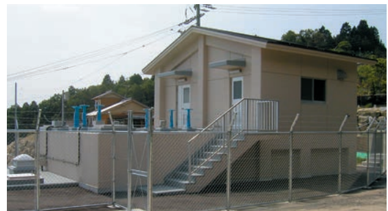
西ノ入配水池
