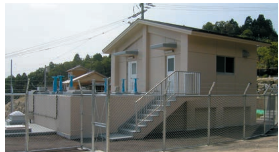
西ノ入配水池
